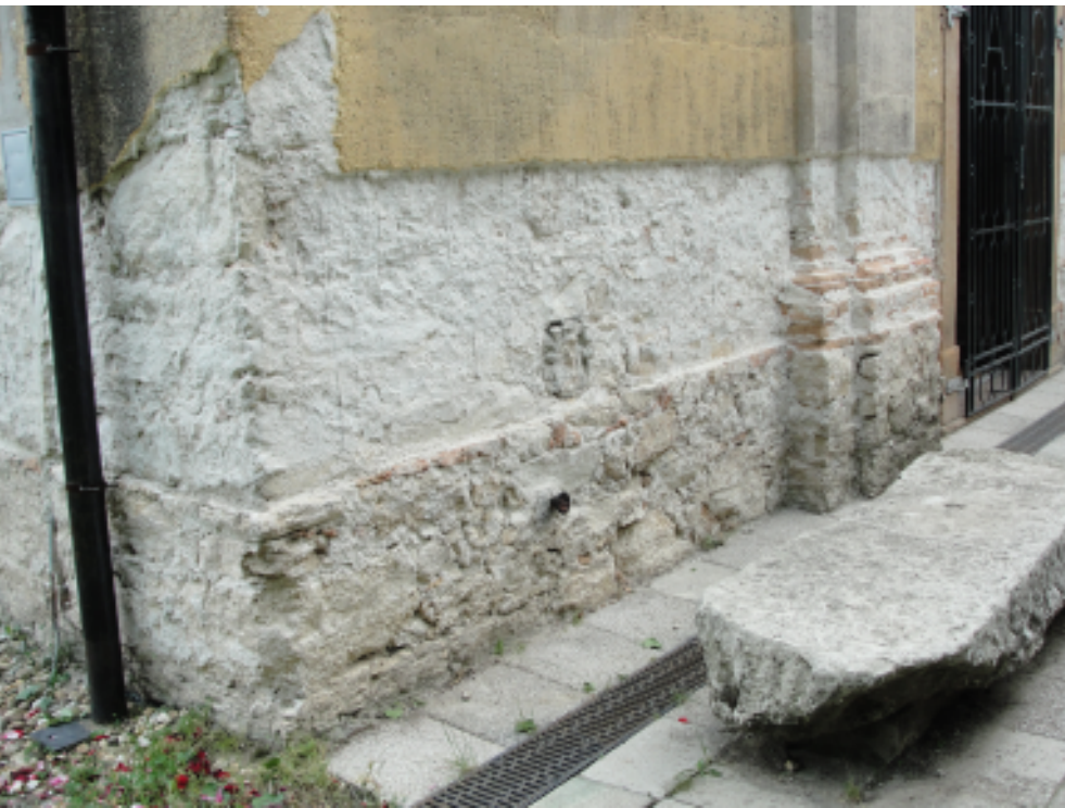
A közeli templom falában található magassági csap, innen vezettük le a felméréshez használt magassági alappontokat.
